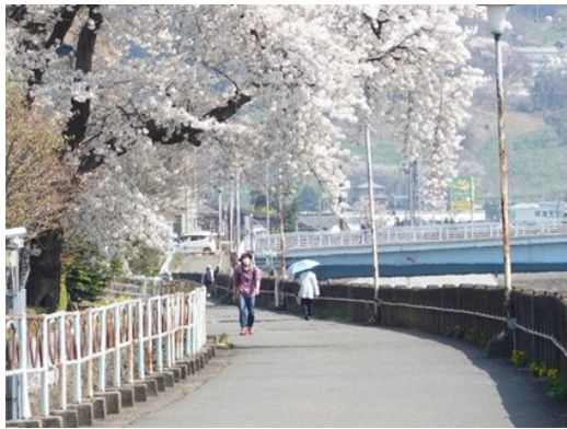
明治橋上流 (2022/4/21 撮影)
