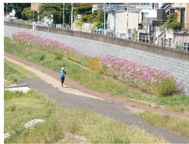
明治橋上流 (2021/9/7 撮影)
